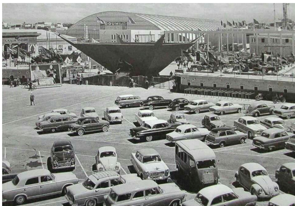
Vue générale de la F.I.C. en 1960
